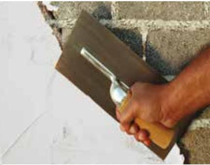
Recubrimiento en polvo base cemento. Modificado con resinas y agregados de granulometría controlada para dar un acabado final tan terso como el yeso.
