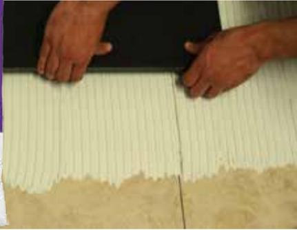
Adhesivo cemento, modificado con polímeros de calidad superior, diseñado para instalar revestimientos vidriados y pétreos en condiciones que requieran adherencia extrema.
