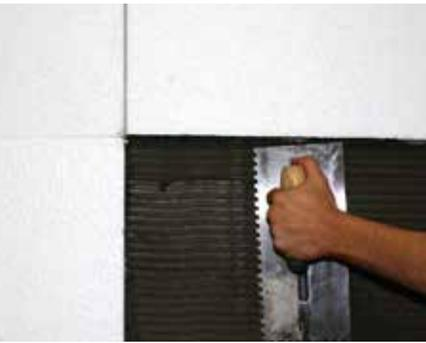
Basecoat forma parte del sistema de aislamiento térmico a base de poliestireno. Utilizado para mantener la temperatura interior confortable. Está diseñado a base de mezclas de cemento, agregados y aditivos químicos que al mezclarse con agua forman una pasta que puede utilizarse como adhesivo y recubrimiento de paneles de poliestireno (FOAM)
