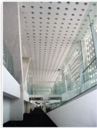
Proyecto: Aeropuerto Internacional de la Ciudad de México T2 Ubicación: México, D.F. 2007
