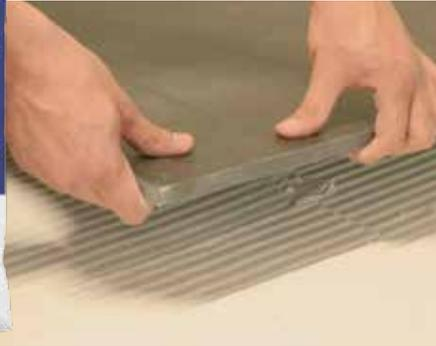
Adhesivo base cemento modificado con agregados y químicos especiales, diseñado para pegar piezas cerámicas, porcelánicas y petreos de gran tamaño y peso.
